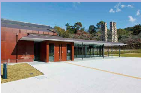
葦山反射炉 (静岡県伊豆の国市)
