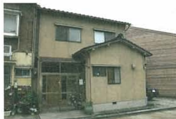
伝統的建造物以外の建造物の修景 (金沢市東山ひがし)
