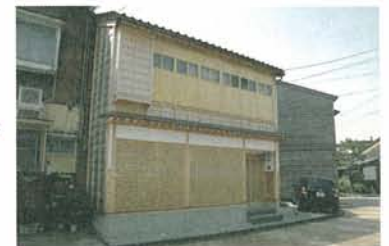
建築線を周囲の伝統的建造物と合わせ、修景基準に合わせて屋根、外壁、建具等を歴史的な風致に調和するよう改造しました。
