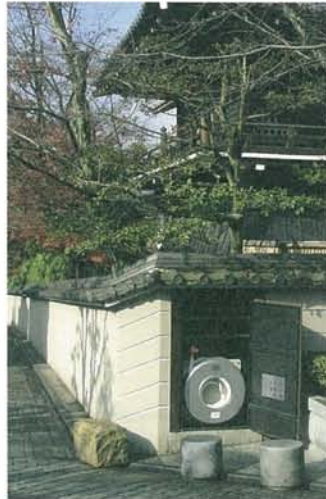
消火栓の設置（京都市産寧坂）
