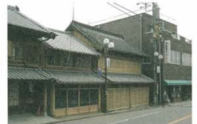
経年劣化による各部破損箇所を直し、構造補強を行いました。また、パラペット等を撤去し、正面外観を復しました。
