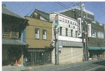
伝統的建造物の修理 (香取市佐原)
