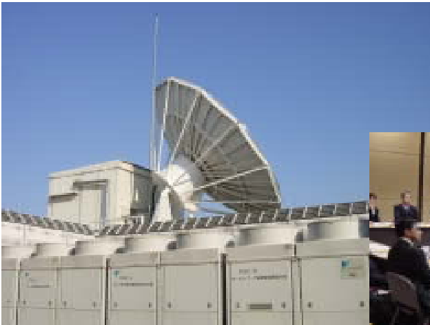
図8 衛星通信用のパラボラアンテナ
