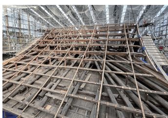
建造物の修理状況
