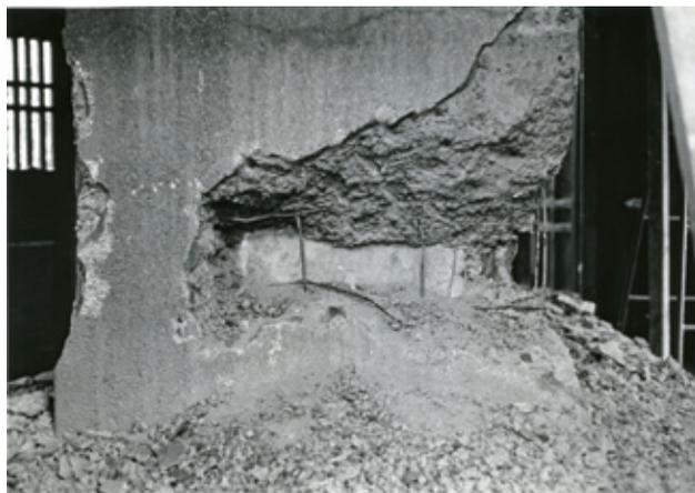
コンクリート除去作業中に現れた細い丸鋼
