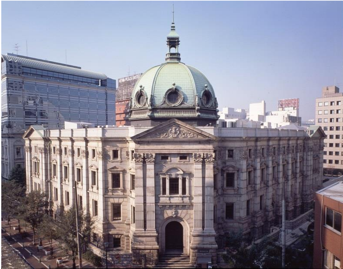
神奈川県立歴史博物館旧館(国指定重要文化財) 【横浜正金銀行本店本館 1904年竣工】
