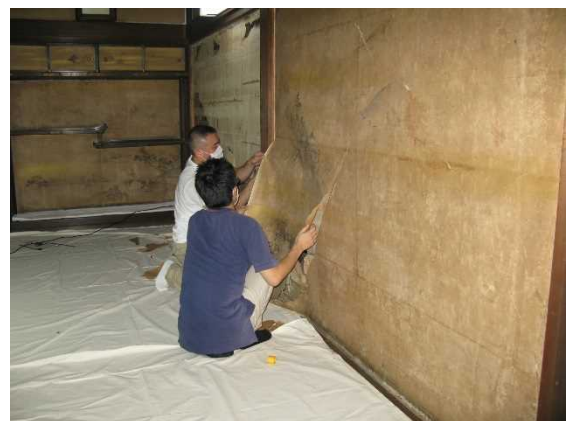
障壁画取り外し作業
