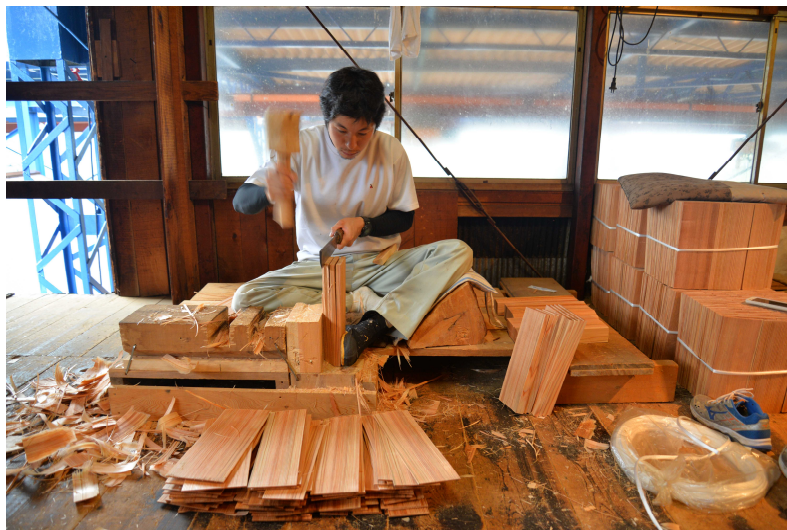
屋根板製作の様子
