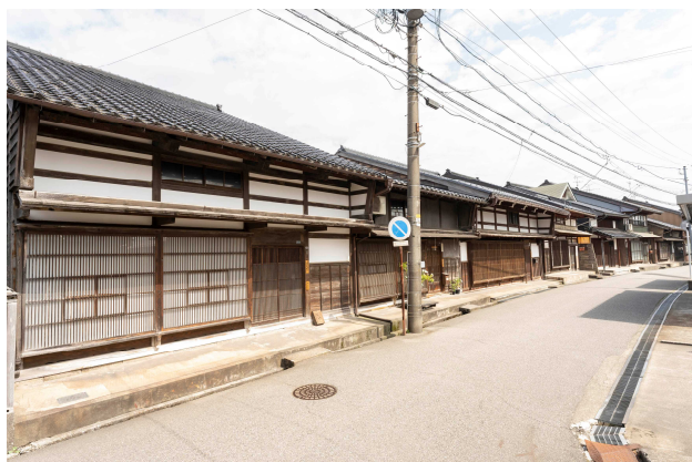
【写真 1】切妻造平入で、二階の柱と貫を現した 当地域特有の町家が並ぶ町並み
