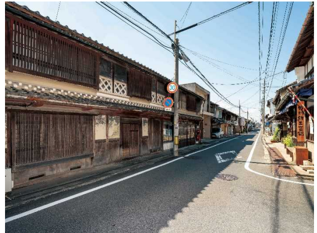
【写真 2】 出雲往来沿いの伝統的な町家
