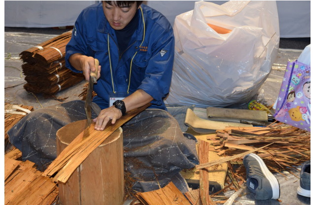
ひわだぶき こしら 檜皮葺材料の拵え
