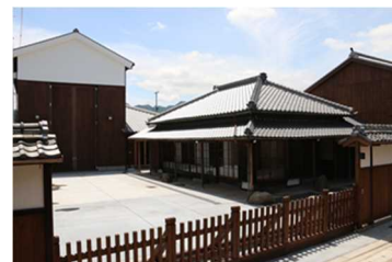
「関の山車」会館整備後
