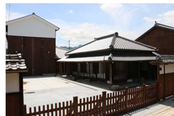
「関の山車」会館整備後
