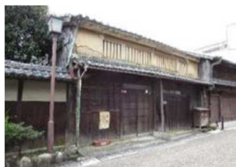
「関の山車」会館 修理前の管理展示棟(主屋)
