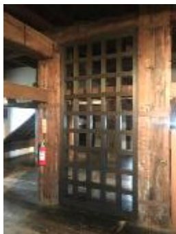
「天守閣の木製格子壁による補強」
