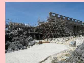
史跡「北大東島燐鉱山遺跡」の石積修理（沖縄県北大東村）
