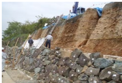
伝統工法による石垣保存改修
