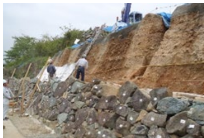
伝統工法による石垣保存改修
