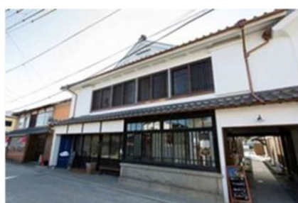
旧久富家住宅取得・保存改修
