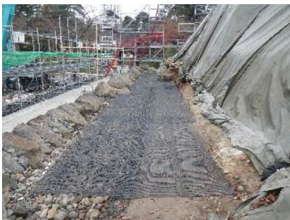
(参考) 裏込めのぐり層などへ高強度のシートを敷き込んで補強
