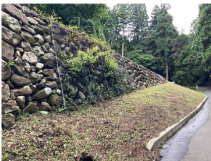
(参考) 石垣からの落石から、前面の園路を守る落石防止ネット
