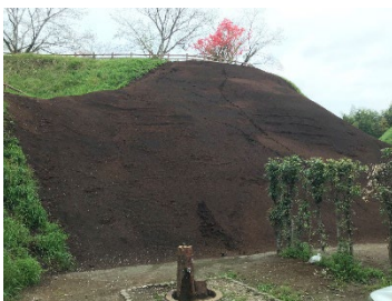
(参考) 長繊維の吹付と杭の打ち込みによる斜面保全
