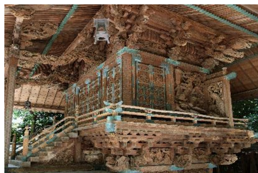
外観 南東より
