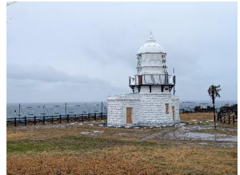
外観 南西より
