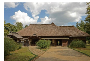
旧長谷川家住宅
