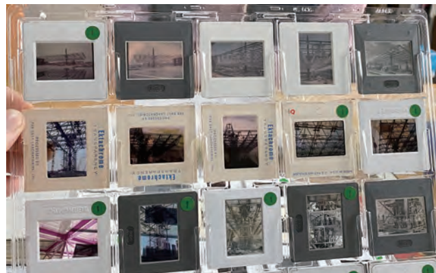
大阪万博お祭り広場大屋根施工時写真
