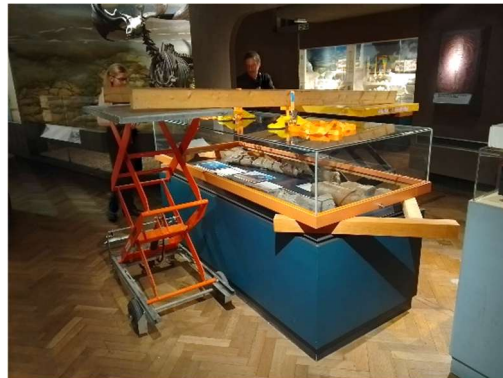
取り外しに使用した資機材
