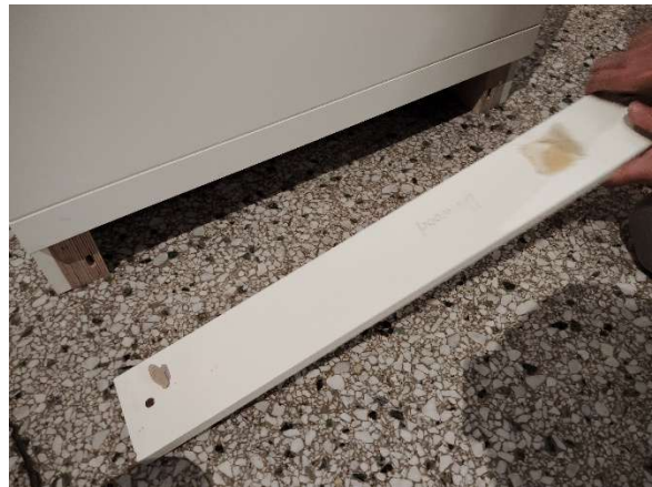
展示ケース四隅の足部分を隠していた板を外したところ
