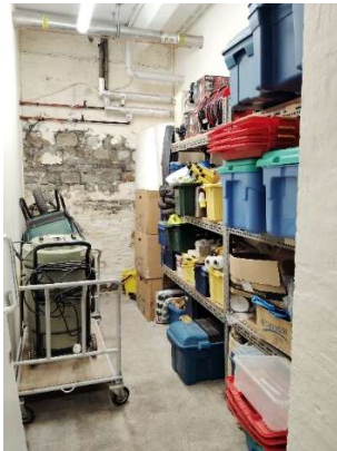
緊急用資機材を入れた倉庫 (展示室付近)
