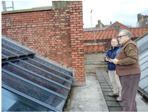
展示室上にあたる屋上の様子を確認しに行った
