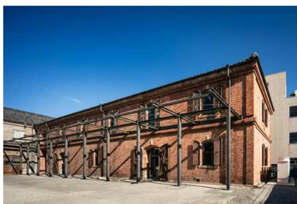
旧富岡倉庫（世界遺産センター）
