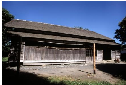
旧樋口家農家住宅
