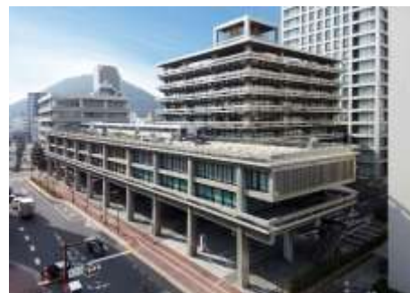
香川県庁舎旧本館及び東館
