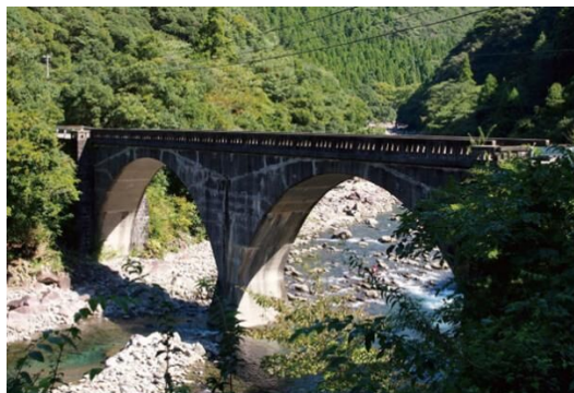
＜旧魚梁瀬森林鉄道施設二股橋＞
