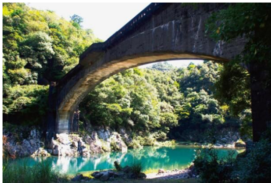
＜旧魚梁瀬森林鉄道施設堀ヶ生橋＞
