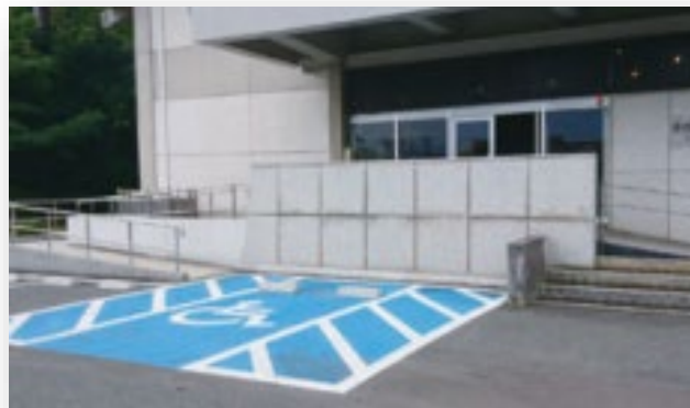
新たに設置したスロープと身障者用駐車場 (写真提供：本間美術館)
