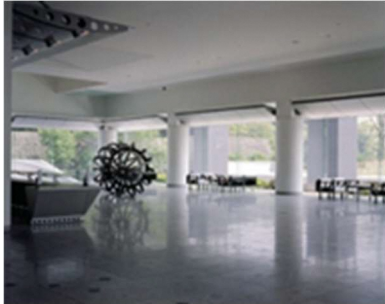
【エントランスホール：和歌山城を望む開放的なガラスウォール。床には「ひふみ石」となるよう 10×10 センチの亜鉛チップをはめ込んだオリジナルのテラゾー（人造大理石）が用いられている】
