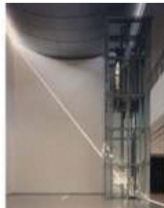
【エントランスホールのエレベーター：「近代＝機械の時代」の象徴として機械と構造を見せるシースルーとなっている】
