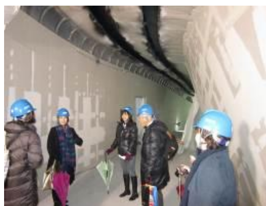
(建設中の DDP 内観)
