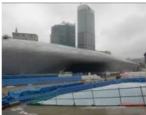
(建設中の DDP 外観)
