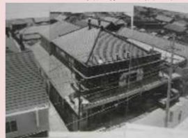
2代目掛川銀行の解体前の写真
