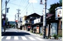
西外堀事業箇所の現状
