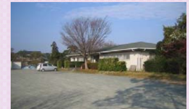
整備箇所の現状
