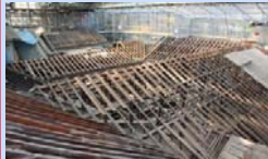
浄土寺の保存修理 (庫裏及び客殿)
