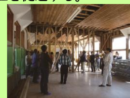
工事途中の公開
