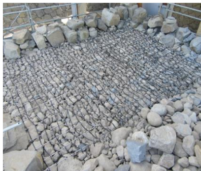
石垣内部栗石の網目状シート補強
