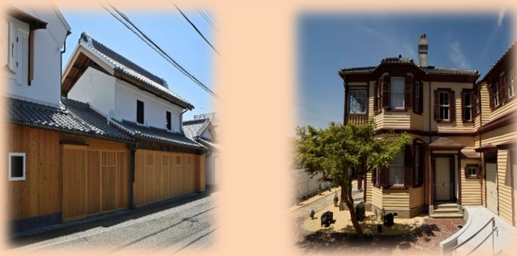
伝統的建造物の公開活用
