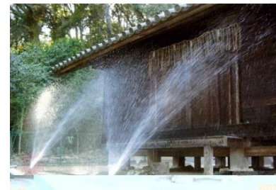
《消火施設(放水銃)の設置》
