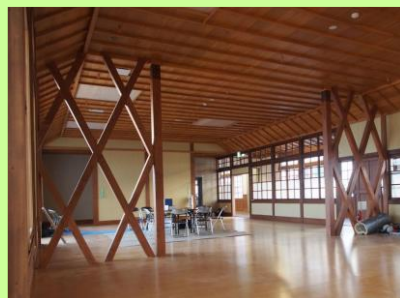
耐震対策装置の設置
