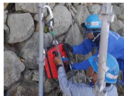
構造調査 (レーダー探査)
