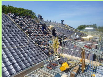
建造物の機能維持
