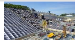
（建造物の修理）
