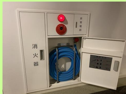
防火施設の設置
