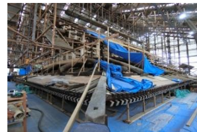
<建造物半解体修理の様子> 重要文化財 本隆寺本堂ほか2棟 (京都府京都市)
