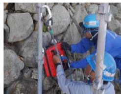
構造調査 (レーザー探査)
