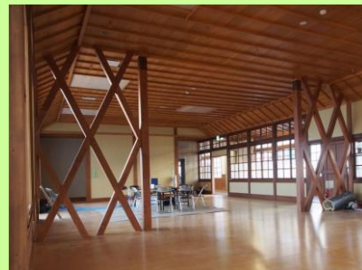
耐震対策装置の設置
