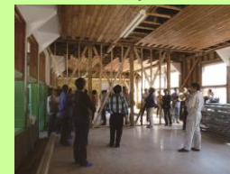
工事途中の公開
