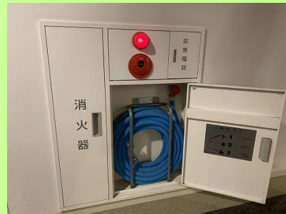
防火施設の設置
