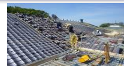
(建造物の修理)
