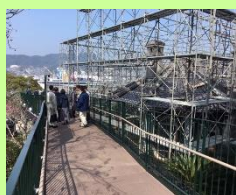
工事を見学できる仮設道路を設置
