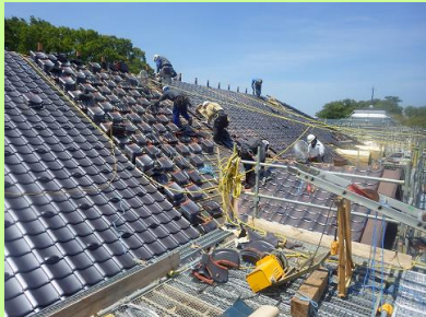
建造物の機能維持
