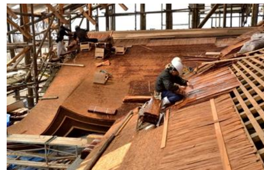
<建造物屋根修理の様子>
