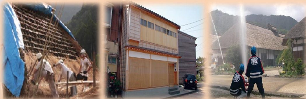
修理・修景、防災・耐震の促進
