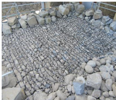
石垣内部栗石の網目状シート補強
