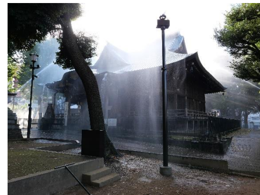
<放水銃放水試験の様子>
