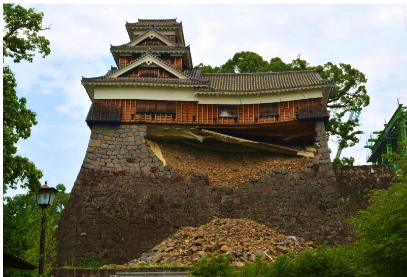
熊本城石垣の地震被害
