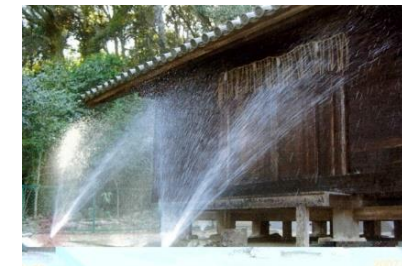
《消火施設(放水銃)の設置》
