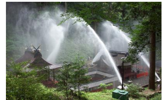
《消火施設(放水銃)の設置》
