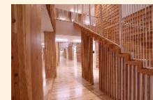
耐火木造の校舎
