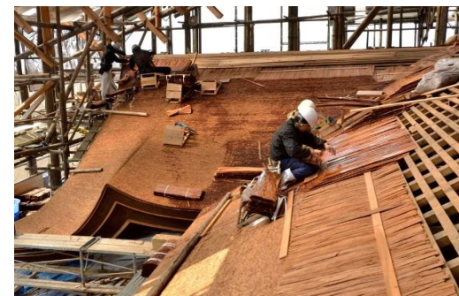
国宝清水寺本堂屋根施工の様子（京都府）
