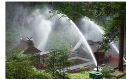
《消火施設(放水銃)の設置》
