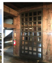
松江城天守の木製格子壁による補強
