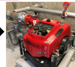
老朽化した消火ポンプの更新
