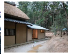
保存管理施設の設置
