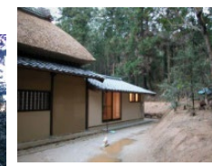
保存管理施設の設置
