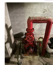
老朽化した消火ポンプの更新
