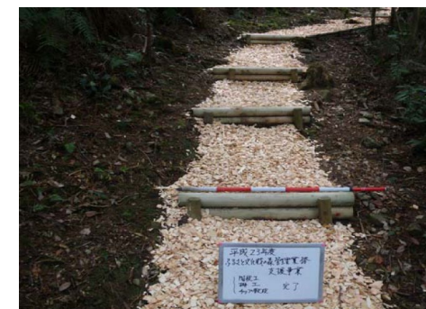
管理業務のための通路整備
