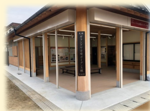
史跡「ランドヤ古墳」のガイダンス施設整備（大分県日田市）
