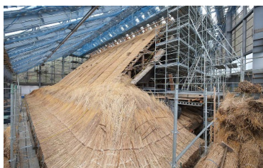
<建築物解体修理の様子> 重要文化財 天徳寺本堂ほか2棟 (秋田県)
