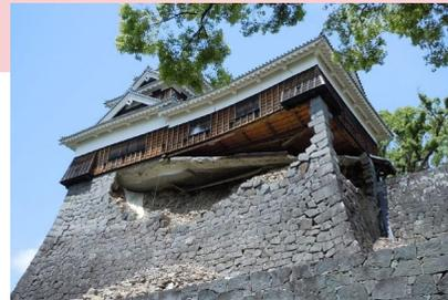
大型地震により石垣が崩壊
