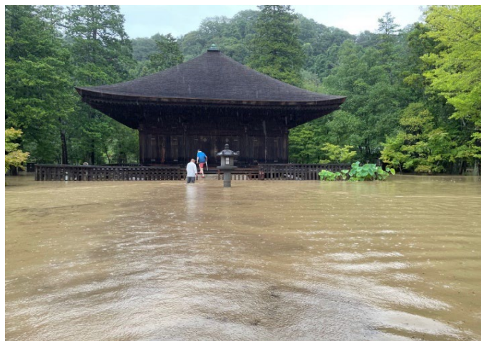
国宝 白水阿弥陀堂 （福島県いわき市） 令和5年9月台風13号による浸水被害
