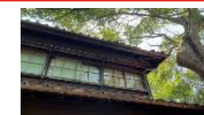
(建造物の修理)
