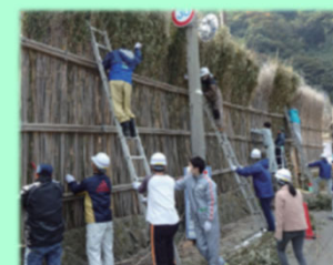
住民参加による修理 (石川県輪島市)
