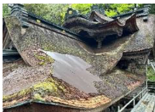
檜皮葺屋根の経年毀損 (金属板にて応急処置) 【重要文化財 大瀧神社本殿及び拝殿 (福井県越前市)】
