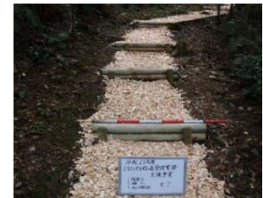
管理業務のための通路整備
