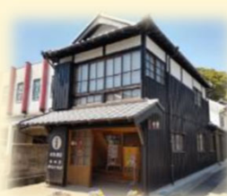
<佐賀県 嬉野市塩田津> 公開活用施設
