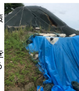
熊本地震で亀裂が入った釜尾古墳
