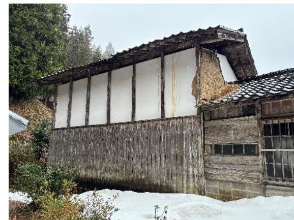
重要文化財黒丸家住宅米蔵ほか （石川県珠洲市） 令和6年1月能登半島地震による土壁の剥落
