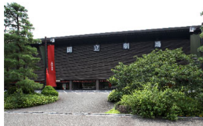
閉場中の国立劇場
