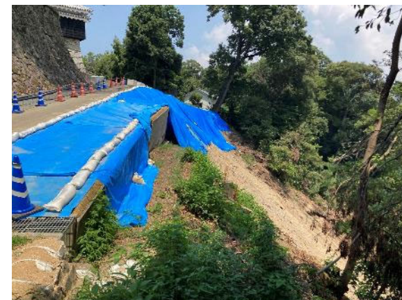
史跡松山城跡 （愛媛県松山市） 令和6年7月豪雨による斜面崩落被害
