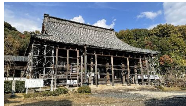
重要文化財 西福寺御影堂 （福井県敦賀市）
