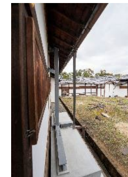
耐震補強イメージ （R5実施 重要文化財 二条城）
