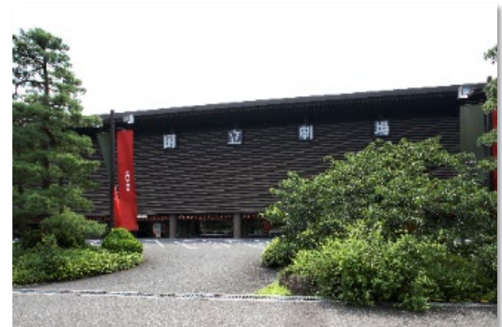
閉場中の国立劇場
