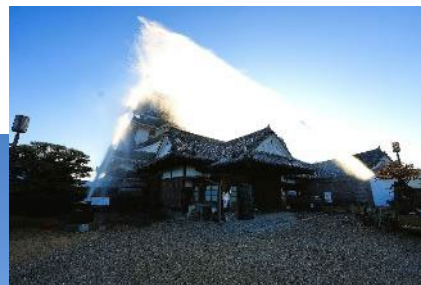
放水銃稼働イメージ （R5設置 重要文化財 高知城）
