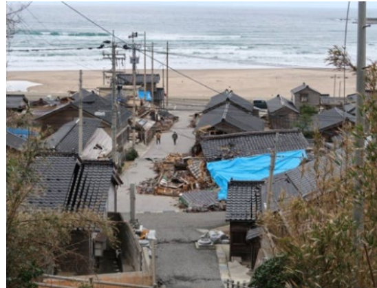
伝統的建造物群：黒島地区 （石川県輪島市） 令和6年1月能登半島地震による倒壊
