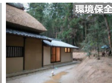
保存管理施設の設置
