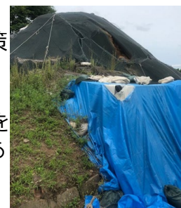
熊本地震で亀裂が入った 釜屋古墳
