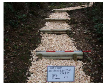
管理業務のための通路整備
