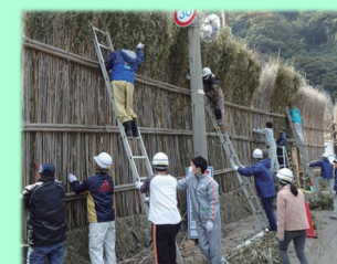
住民参加による修理 （石川県輪島市）
