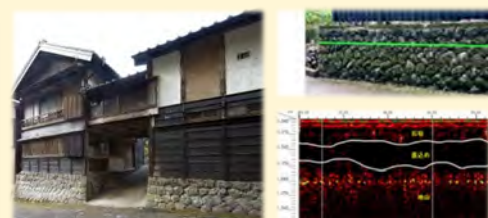
＜静岡県 焼津市花沢＞ 石垣耐震補強のためのレーダー探査
