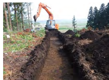
現地での試掘・確認調査
