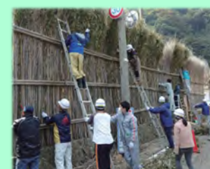
住民参加による修理 (石川県輪島市)
