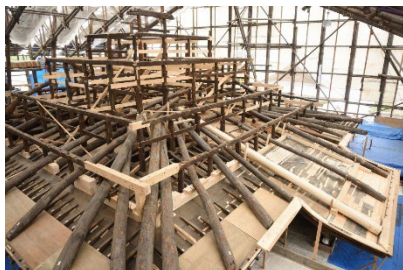
小屋組の修理状況
