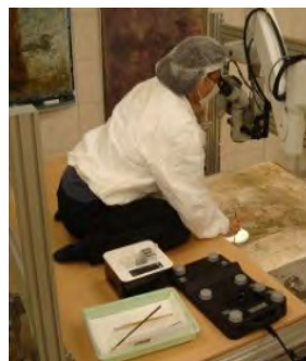
壁面メンテナンス作業
