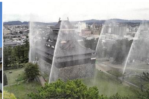
放水銃稼働イメージ （R6設置 国宝 松江城天守） （島根県松江市）
