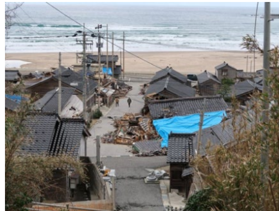
重要伝統的建造物群保存地区 黒島地区 （石川県輪島市） 令和6年能登半島地震による倒壊
