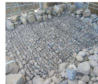
石垣内部栗石の網目状 シート補強
