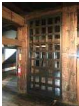
「天守閣の木製格子壁による補強」
