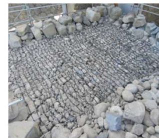
石垣内部栗石の網目状 シート補強
