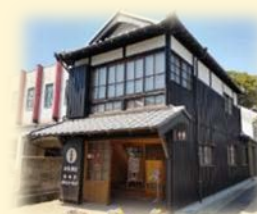
<佐賀県 嬉野市塩田津> 公開活用施設
