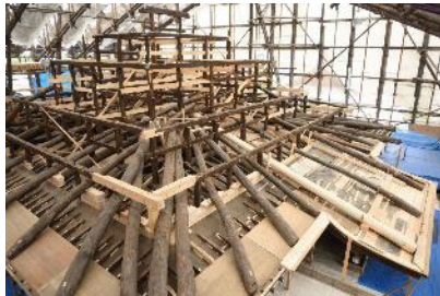
小屋組の修理状況
