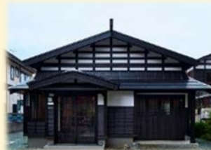
<秋田県 仙北市角館> 修景事業で新築した建造物
