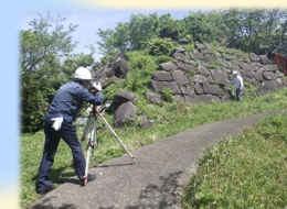
史跡「勝本城跡」での石垣測量（長崎県壱岐市）
