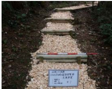
管理業務のための通路整備
