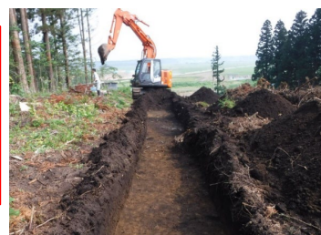
現地での試掘・確認調査
