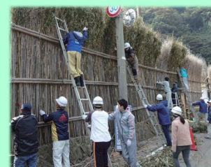
住民参加による修理 (石川県輪島市)
